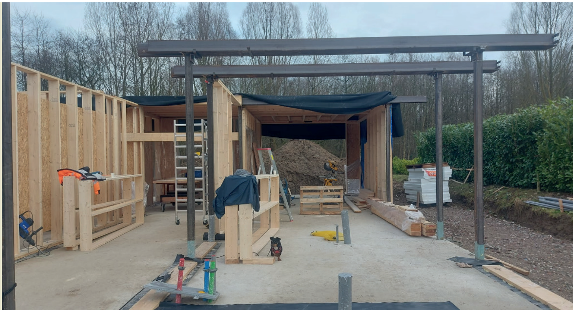
> uitvoering houtskeletbouw (HSB) - februari 2025
